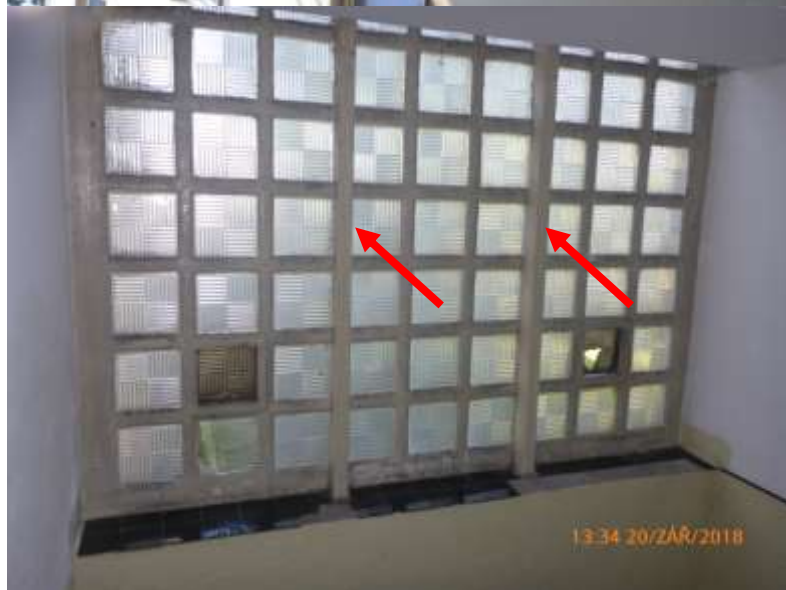
Pohled na sklobetonovou stěnu schodiště z interiéru. Betonové svislé ztužující sloupky byly zjištěny s oplechováním na vnitřní straně.
