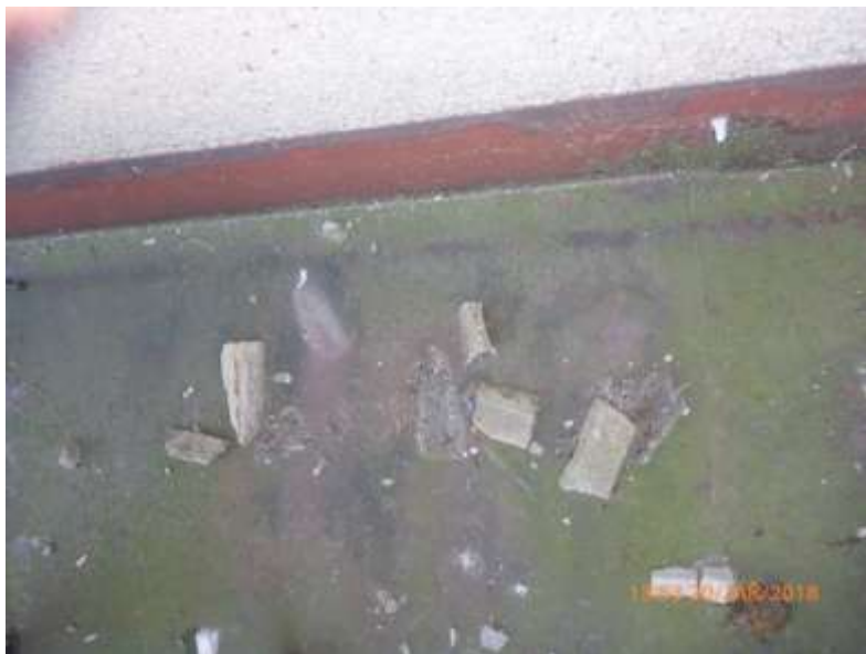
Proces degradace betonu s roztrháním betonových rámečků a zálivkové malty je aktivní. O tom svědčí padající kusy betonu na přístřešek vstupu.
