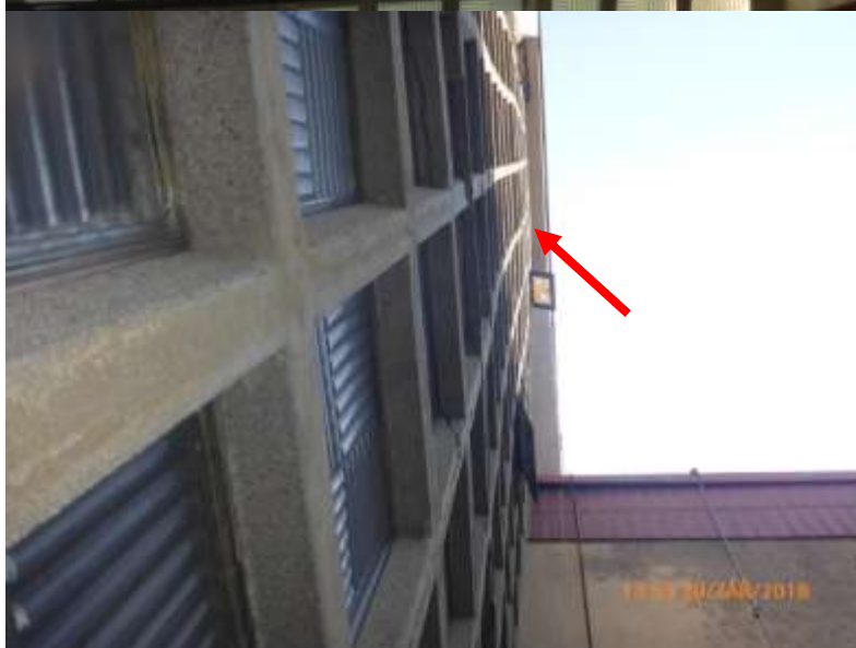
Vyboulení sklobetonové stěny při pohledu z exteriéru !!!
