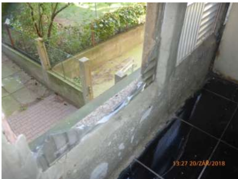
Rozbité jednotlivé skleněné tvárnice.
