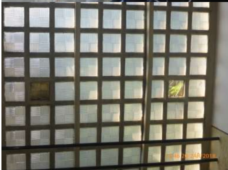
Odtržení sklobetonové stěny od ztužujícího sloupku o cca 30mm!!!
